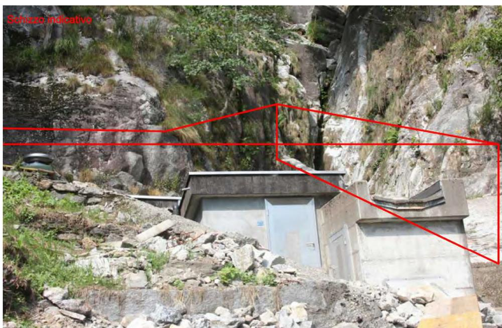
Figura 3: Muro di sponda e soletta inclinata – Schizzo indicativo
