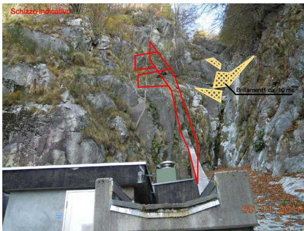
Figura 1: Muro di contenimento dei flussi detritici – Schizzo indicativo
