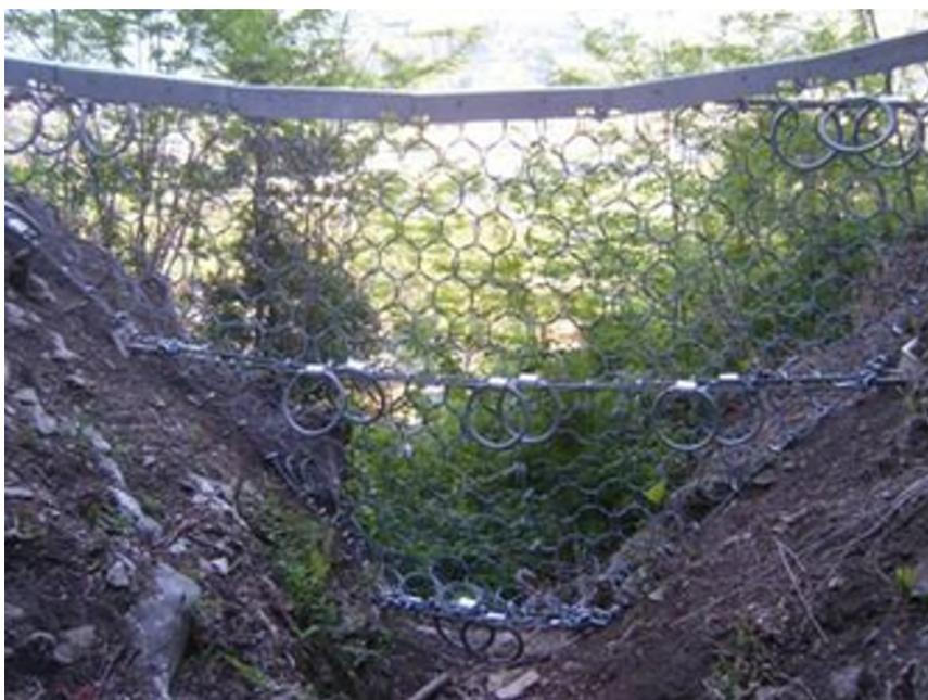
Figura 8: Rete di ritenuta (tipo "debris flow") – Esempio
